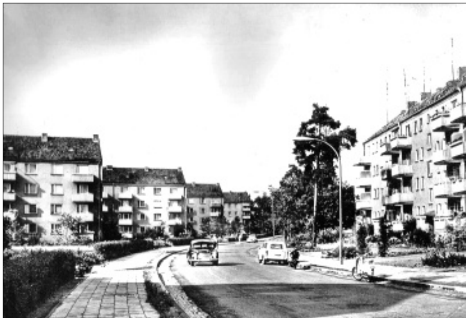
Dieses Foto entstand vermutlich in den 1960er Jahren. Die Neubauten in der Wildparkstraße in Westend entstanden Ende der 50er bis Anfang der 60er Jahre des 20. Jahrhunderts, zum Teil in Eigenleistung der Mitglieder der damaligen Arbeiterwohnungs-genossenschaft, heute Wohnungs-genossenschaft 1893 Eberswalde eG...
