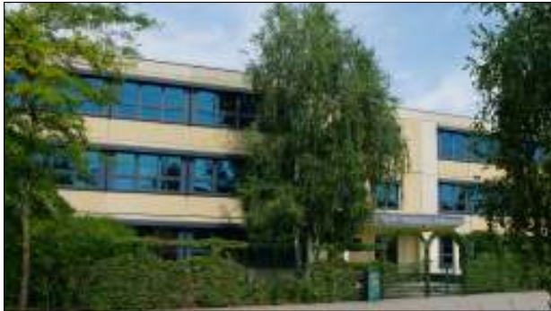
Schick sieht das ehemalige Gebäude des Beruflichen Gymnasiums in der Kyritzer Straße aus. Von außen zumindest. Wie sich nun herausstellte, gab der Landkreis nach rund 15 Jahren Nutzung marode Bausubstanz an die Stadt zurück.
