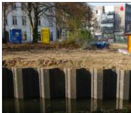
Das Gehölz des kleinen Parks an der Michaelisstraße wurde gerodet, um Baufreiheit zum Einspunden der Schwärze zu schaffen.
