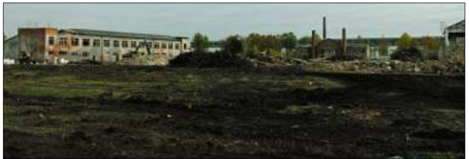
Ende Oktober 2010 waren die Abrißarbeiten auf dem Gelände des künftigen Solarparks noch im vollen Gange. Für die Holzungsarbeiten wäre nach Ende der Vegetationsperiode noch genügend Zeit gewesen.
